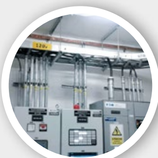
CABLEADO EN DUCTOS Y BANDEJAS PARA FUERZA, CONTROL E INSTRUMENTACIÓN.
